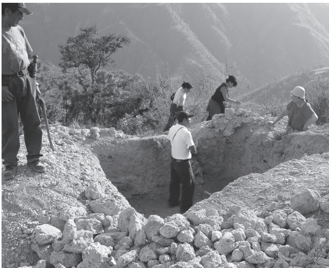
Ett cisternbygge på Funcedescrri.
